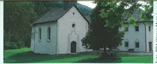
Innerteuchen, „Klösterle“ nach der Außenrestaurierung
