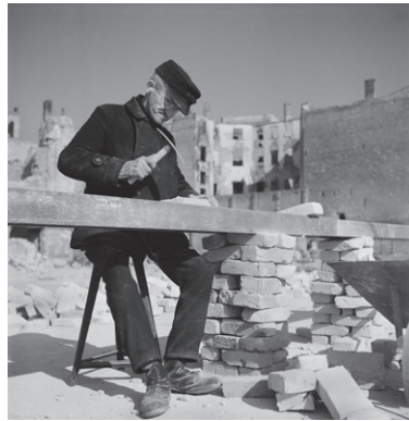
Fundament für den Wiederaufbau, Berlin 1946
